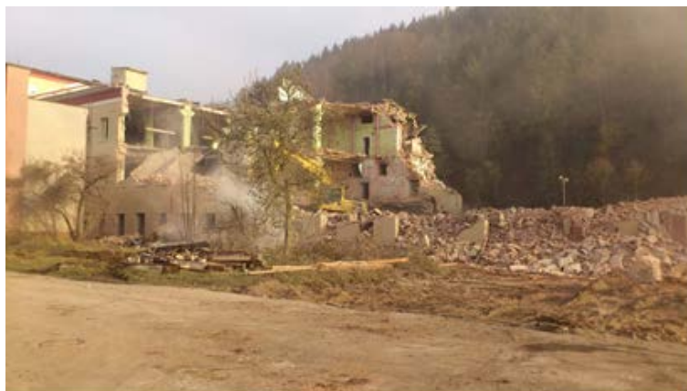
Demolice Texlenu v Horním Starém Městě
