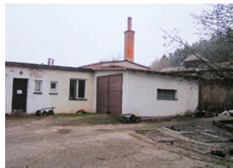
Budova bývalého zahradnictví v Trutnově - Náchodské ulici
